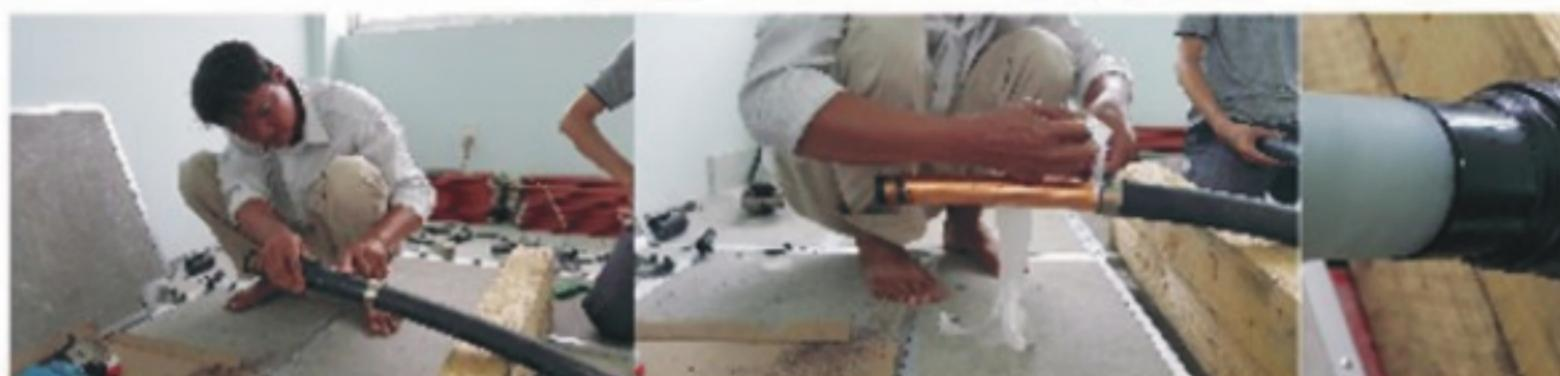
Sau đó 3M đã hướng dẫn cho đơn vị thi công làm lại đầu cáp QTII mới đúng kỹ thuật. Đơn vị thi công sau đó phải bồi chi phí thử nghiệm PD lại toàn bộ đầu cáp ở trạm này và thay thế các đầu cáp bị hỏng.
