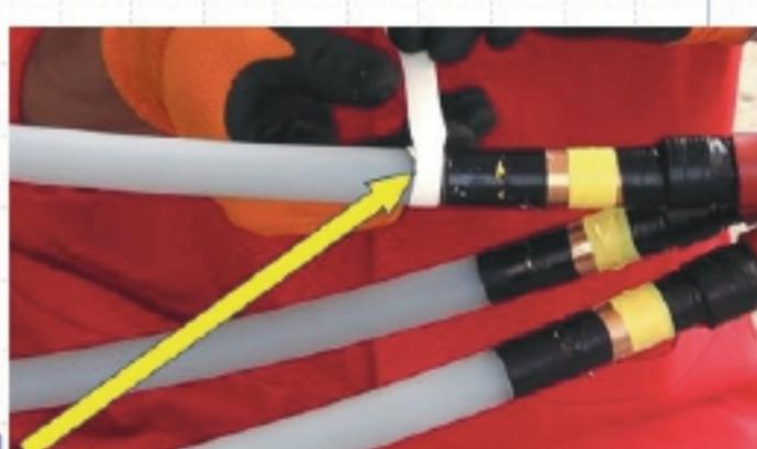
Bước (4): Bôi mỡ silicone và khò nhiệt ống điều áp, chú ý khò đều tay để ống co đều và bám sát vào cáp, tránh khò quá nhiệt để cháy ống điều áp.
