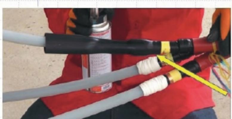
Bước (2) & (3): Cắt bán dẫn, băng đồng và quấn cao su điều áp làm đầy vị trí tiếp giáp bán dẫn và lớp cách điện XLPE.
