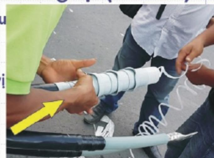
**Bước (6):** Đưa ống đầu cáp vào đúng vị trí và bắt đầu rút, kéo dây lõi đỡ bên trong ra ngoài.
