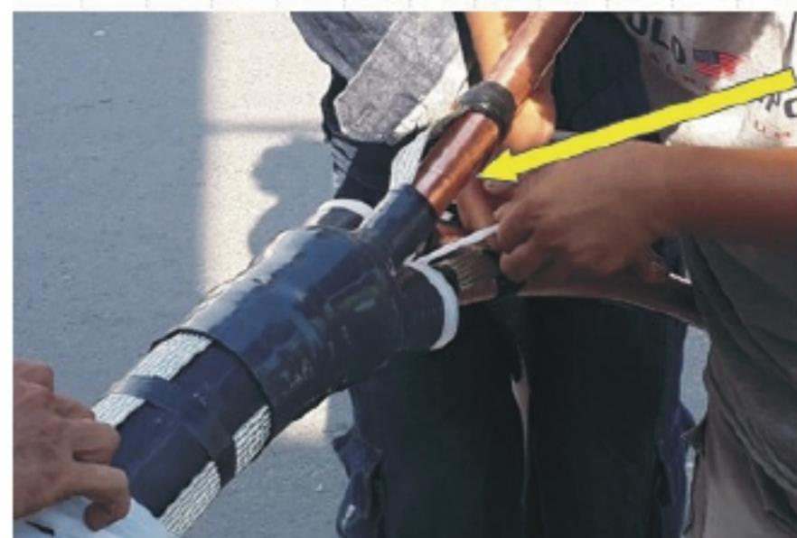
**Bước (1):** Chuẩn bị cáp, gắn dây tiếp địa làm kín và gia nhiệt gắn cổ chia cáp.
