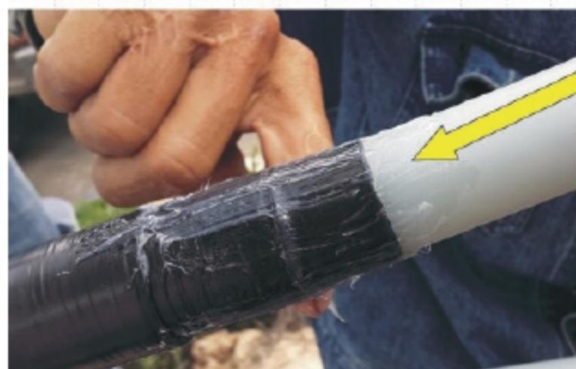
**Bước (5):** Đánh dấu vị trí lắp đặt ống QTII và bôi mỡ silicone điền đầy vị trí tiếp giáp cách điện và bán dẫn
