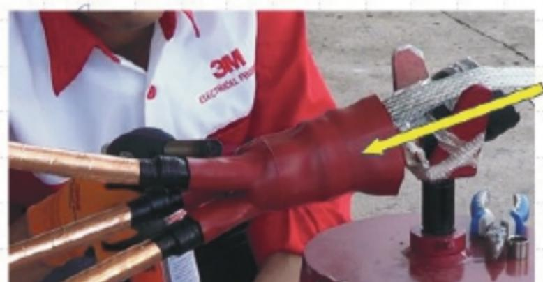
Bước (1): Chuẩn bị cáp, gắn dây tiếp địa, làm kín và gia nhiệt gắn cổ chia cáp.
