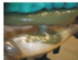
Vỏ cáp được tái tạo bởi sự kết hợp giữa các loại băng và nhựa PU. Băng lưới độn P3F được sử dụng để tạo lên một khoảng không tạo thành khuôn linh hoạt bao xung quanh mối nối, đảm bảo nhựa PU sẽ bao bọc toàn bộ mối nối. Băng sợi thủy tinh chịu lực được sử dụng để gia tăng độ bền cơ học của mối nối. Băng trong suốt tạo lớp bên ngoài để đảm bảo an toàn, dễ quan sát và bọc kín khi đổ nhựa vào.
